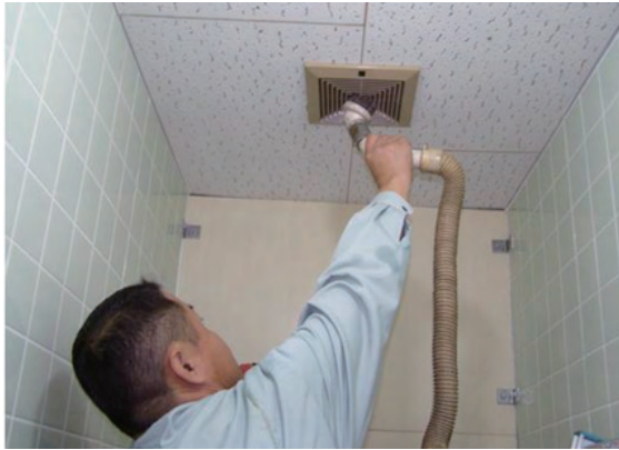
寿光園でのトイレ内換気扇清掃
