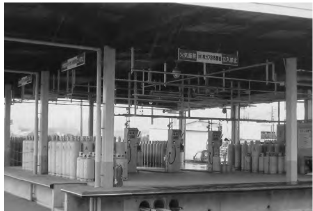
LPガス充填所（鹿屋市田崎町）
