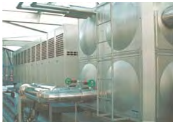
屋上に設置された排熱回収型ヒートポンプ（左）と貯湯槽（右）
