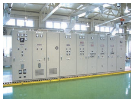
配電盤製作（日置工場内）
