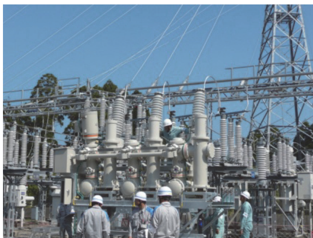
九州電力高尾野変電所工事
