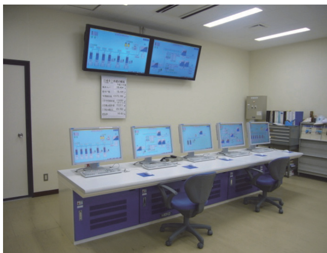
日南市飢肥浄水場水道中央監視装置
