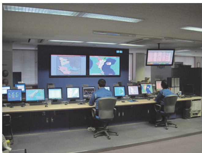
上下水道監視センター「トラスト」(本社2階)
