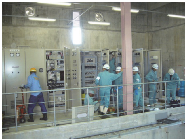
薩摩川内市中村排水機場電気工事
