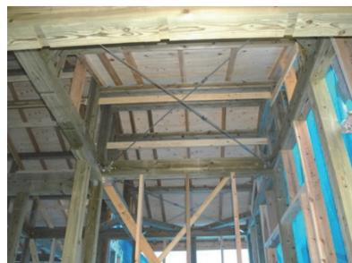
当社設計N邸：水平ブレースや筋交い、火打ち梁で十分な耐震性能を確保。
