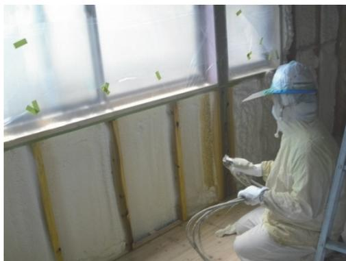
当社設計N邸：壁面や屋根裏に発泡ウレタンを吹付け、隙間無く断熱層を形成する。
