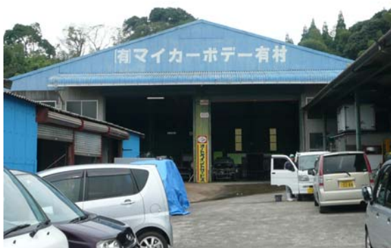
道路沿いに立地する「見せる工場」
