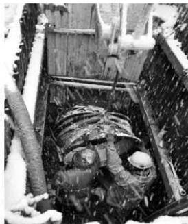
壁の中での水道管の復旧作業
