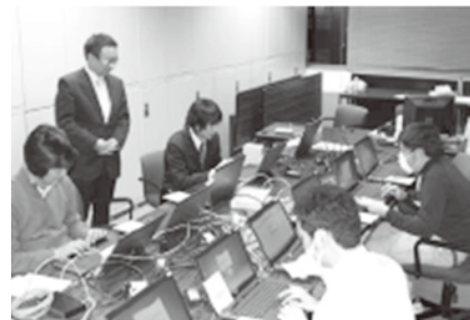
中央会でのネットワーク工事の様子
