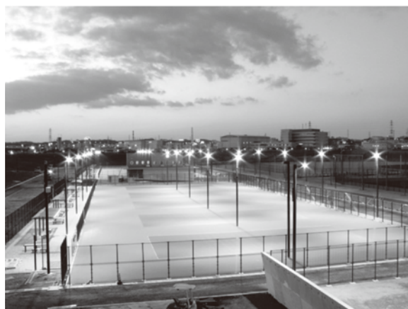
同社が施工した照明設備
