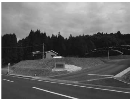
バイオマス用チップ製造のため始良市蒲生町下久徳に造成・新築した始良工場。右奥は山積みされた木材。
