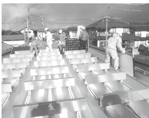
太陽光パネルの設置作業
