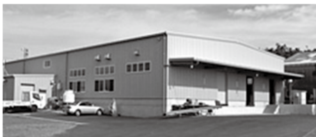
最新の衛生設備を誇る山川の本社工場
