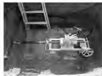
地中管工機による開削（大口径）
