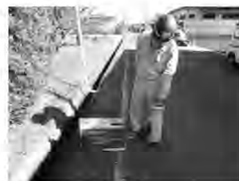
探知機による排水管探査
