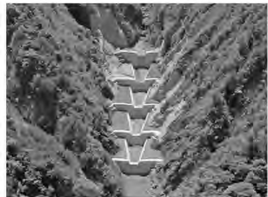
桜島地区治山工事（西道川）
