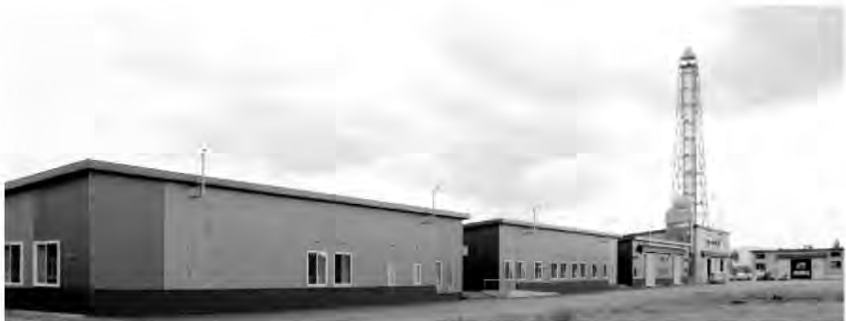
社屋及び工場外観
