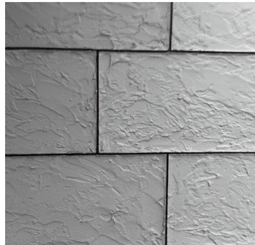
外壁の装飾塗装
