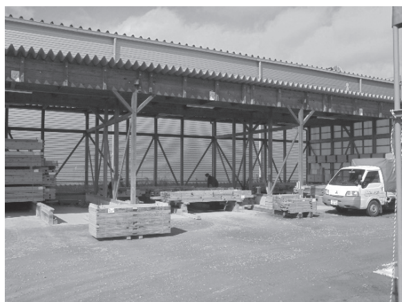
加工のみならず、防蟻処理も行っている
