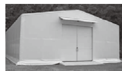
中型テント倉庫施工例
