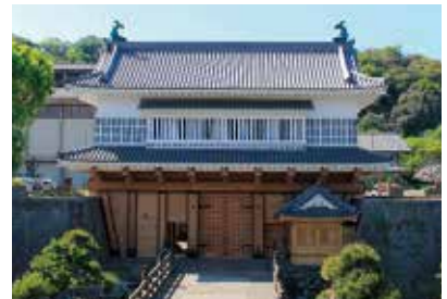
完成した鶴丸城御楼門
