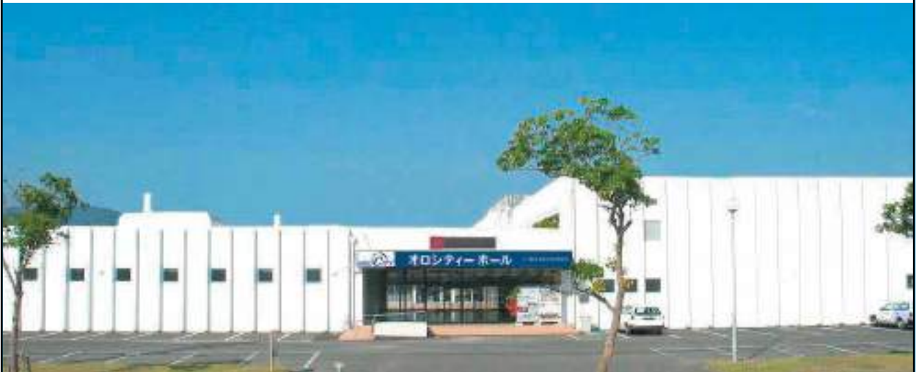
現在外壁改修工事中です。本年3月に完了予定です。
