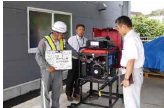
発電機点検立会い
