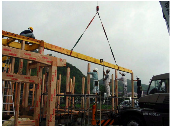
プレカットした8Mの桁材
