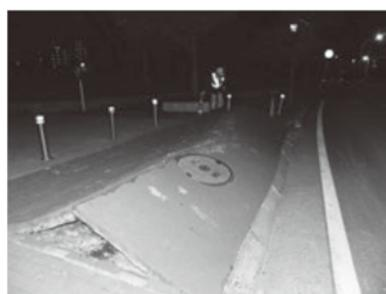
隆起したマンホールによる舗装の被害
