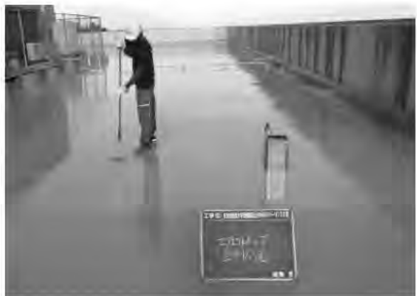
防水施工のようす
