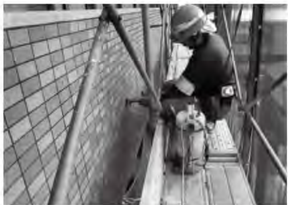
外壁補修のようす
